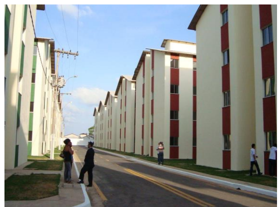
Figura 6: Prédios de apartamentos do conjunto habitacional Mucajá, em Macapá (Fonte: Site Patrimônio de todos).
