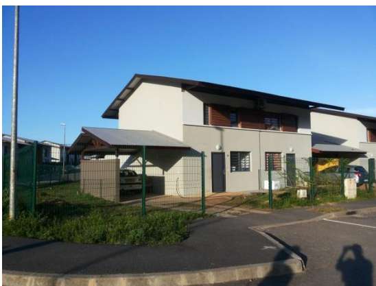
Figura 5: Habitação do conjunto habitacional no bairro Arc en Ciel, em Caiena (Fonte: Alves, Natália).
