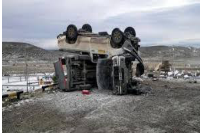
Figura5 Consecuencias en las instalaciones de PAE
