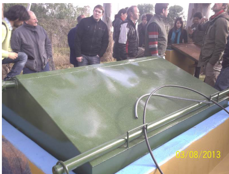
Foto N° 3: Cúpula metálica del biodigestor construido en la escuela N° 44 de la ciudad de Cerrito (Provincia de Entre Ríos, 2013).
