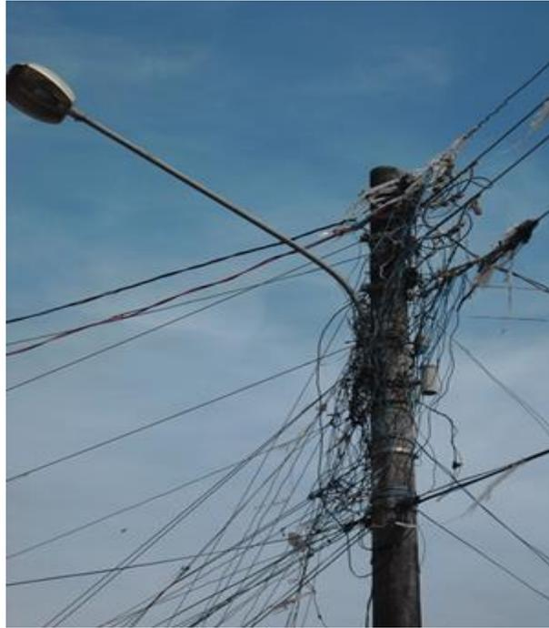
Figura 05: Má condição do fornecimento de energia
